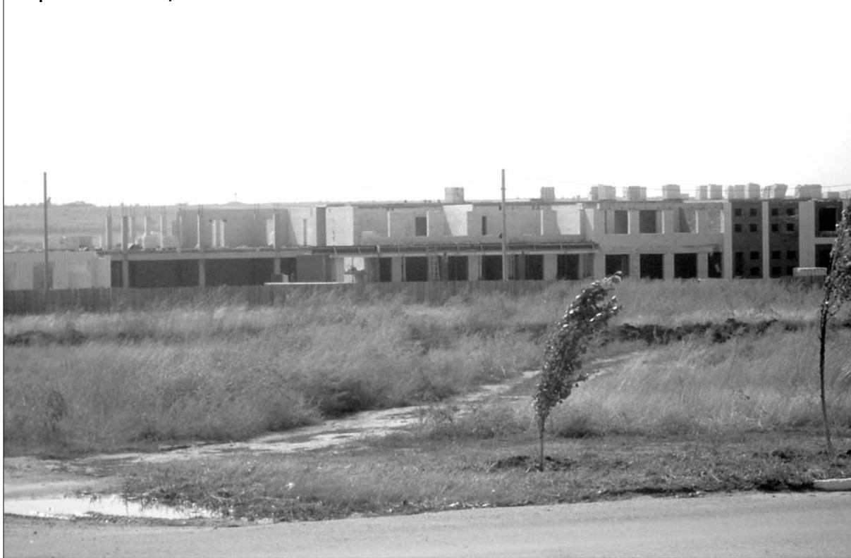
Строительство Нац. гимназии
